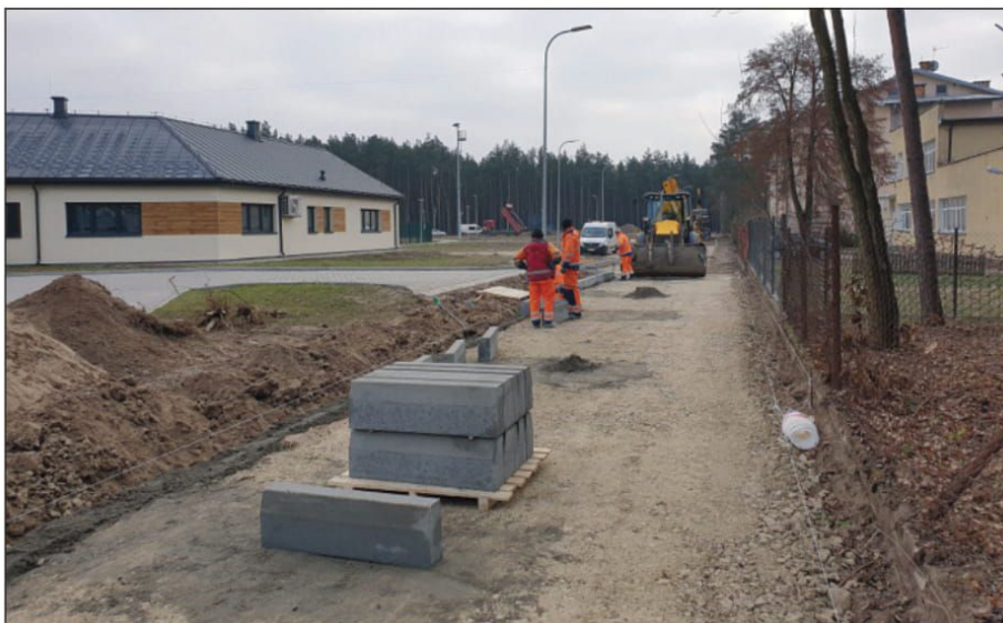
Przebudowa drogi ul. Nauczycielskiej w Kołbieli
