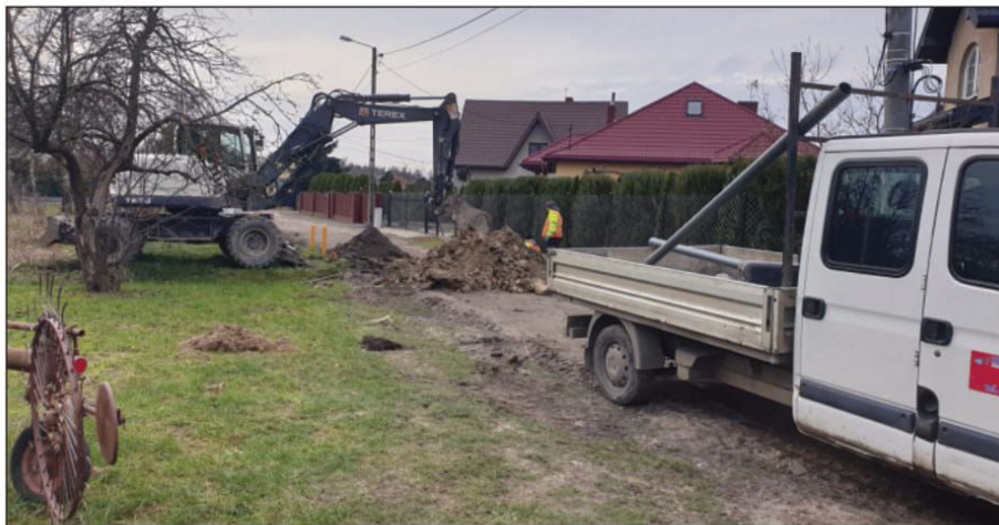
Budowa wodociągu w Człkówce
