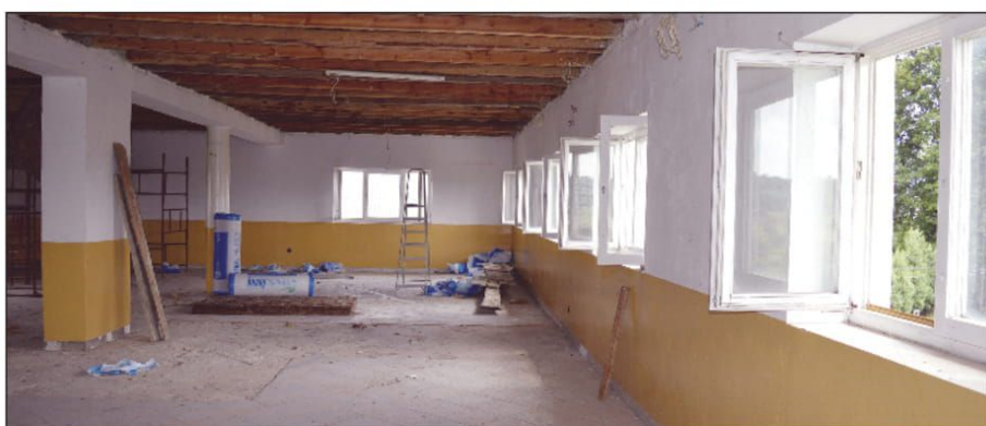
Remont sali na piętrze budynku OSP Kąty
