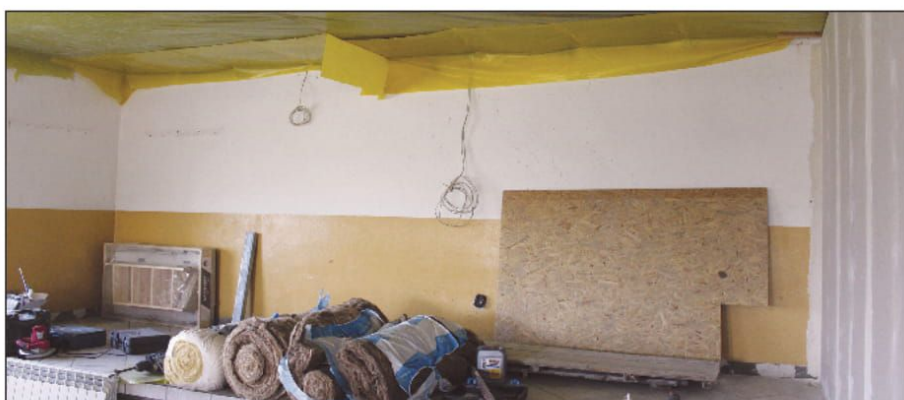
Remont pomieszczenia przeznaczony na filię biblioteki
