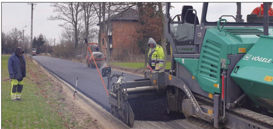
Przebudowa drogi w Woli Sufczyńskiej
